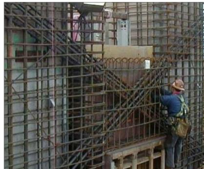
Fig. 5. Armadura de reforço de viga de acoplamento.
